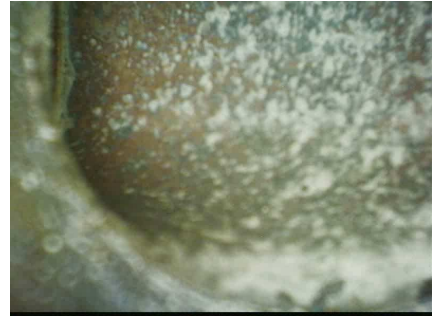
Videoaufnahme einer Kupferleitung Ø 18 mm mittels Spezial-Kamera
