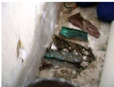
Video: defekte Trinkwasserleitung
